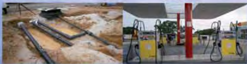
Construction & Installation réseau distribution de Station service
