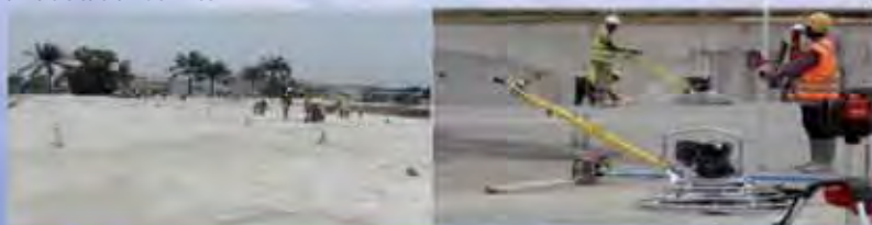
Talochage après coulage Dalle
