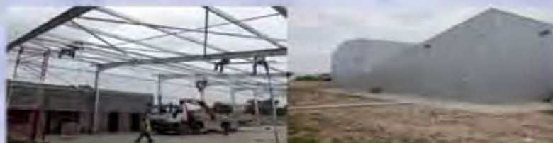
Montage Hangar Couverture & Bardage
