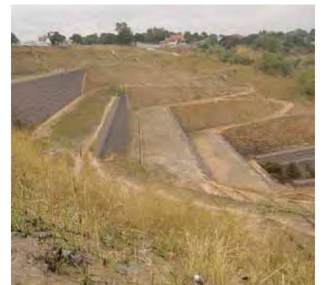
Travaux de maîtrise des érosions.
